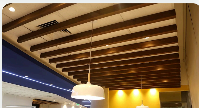
Cielorraso — listones de madera
